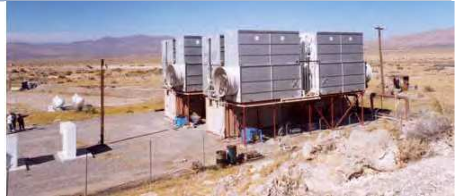
Ilustración 4. Planta eléctrica de ciclo binario en Wendell-Amadee, California. Se aprecia su estructura modular. Su funcionamiento es automático, vigilado por control remoto. (©2000 Geothermal Education Office).
